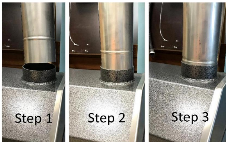
Bild 7. Schornsteinmontage
